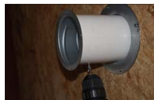
hul bores og den skrues fast
