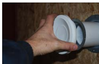
Indblæsningsventilen monteres
