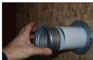
Indblæsningsflangen monteres i røret
