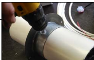
Mur/loftsgennemføring placeres og skrues fast
