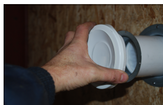
Indblæsningsventilen monteres
