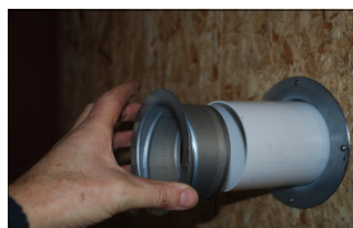
Indblæsningsflangen monteres i røret
