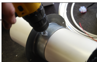
Mur/loftsgennemføringen placeres og skrues fast
